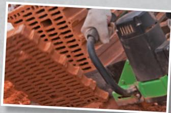
La scie sabre à doubles lames EDB480.1 est spécialement adaptée à la découpe du Poroton® jusqu'à la classe 20.
